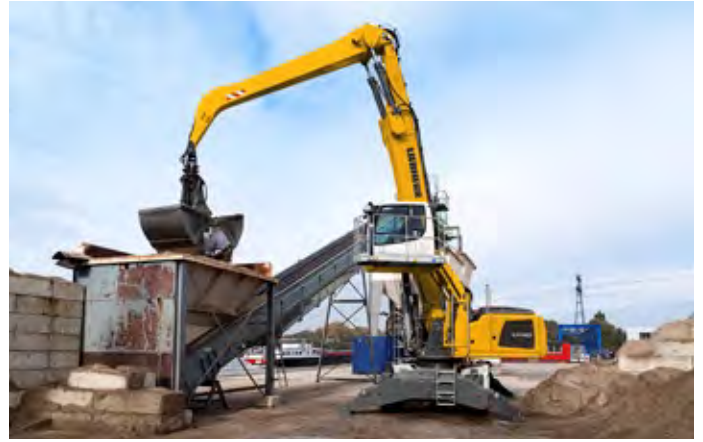
Alimentation d'une centrale à béton avec la LH 40 M Industry Litronic
